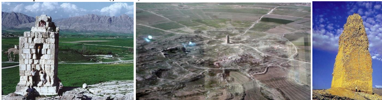
Şəkil 1. Nurabadda Əjdaha qülləsi, İran, Parfiya dövrü; Firuzabadın mərkəzində Zərdüştü qülləsi, Sasani dövrü, yüksəklikdən görünüşü və qüllənin özü.
